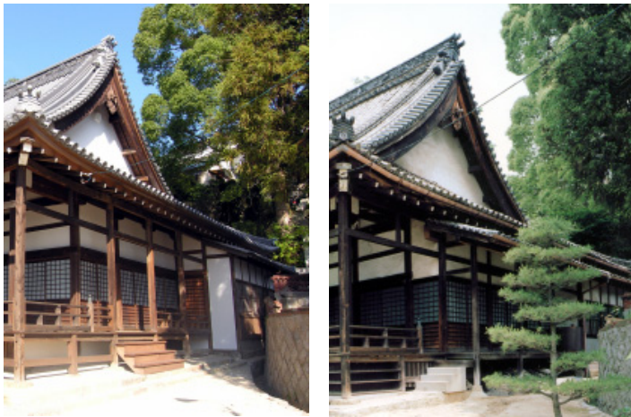
拡張されていた外陣と縁は、もとの形に戻された。写真右が修復前、写真左が修復後。本堂外陣が半間拡張してあった分、屋根も付け足され、階段の位置も変更されていた。
