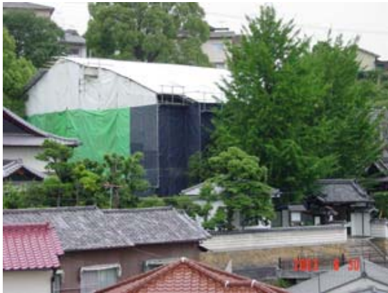
本堂をすっぽり覆う素屋根も完成
